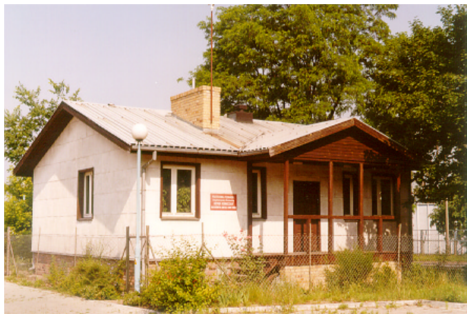
Rys. 1. Obiekt doświadczalny Politechniki Poznańskiej, Instytutu Inżynierii Środowiska.
